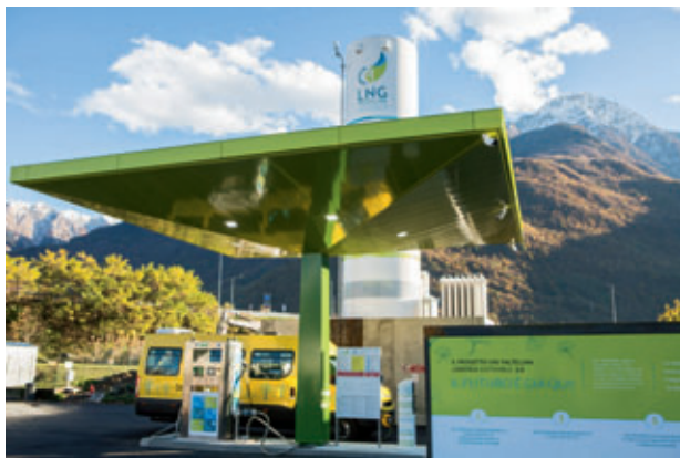
Una stazione di rifornimento Gnl in provincia di Sondrio
